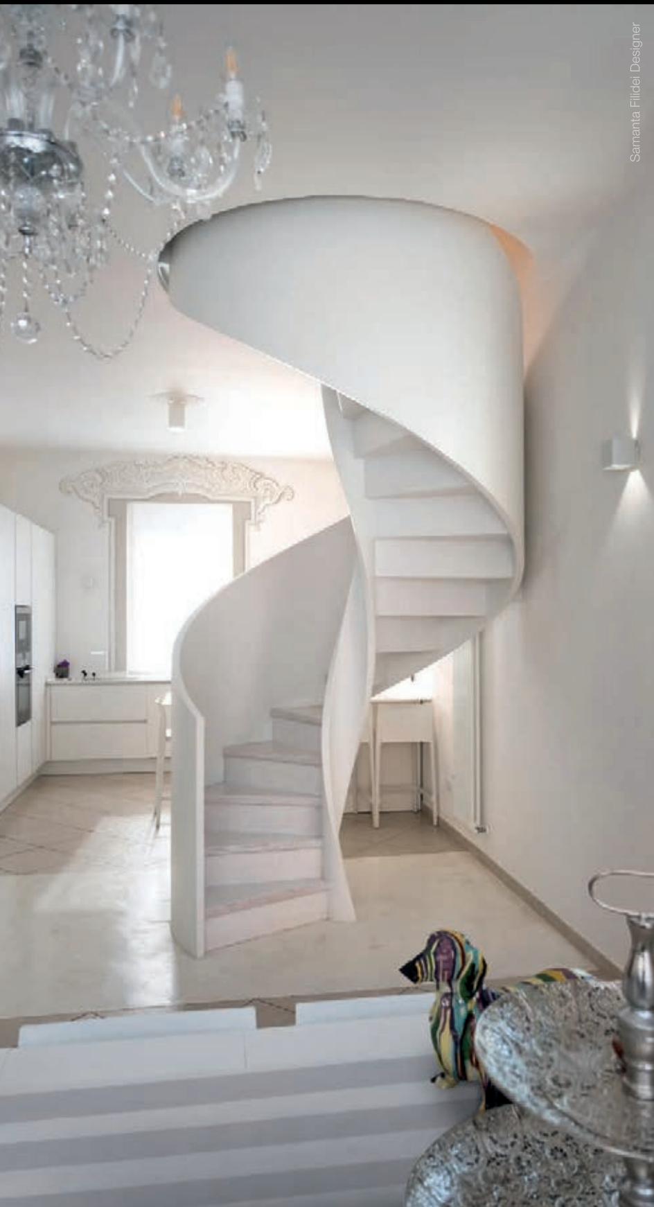
Scala elicoidale in legno (diametro 180 cm) • Wooden helical staircase (diameter 180 cm) • Escalier hélicoïdale en bois (diamètre 180 cm)
