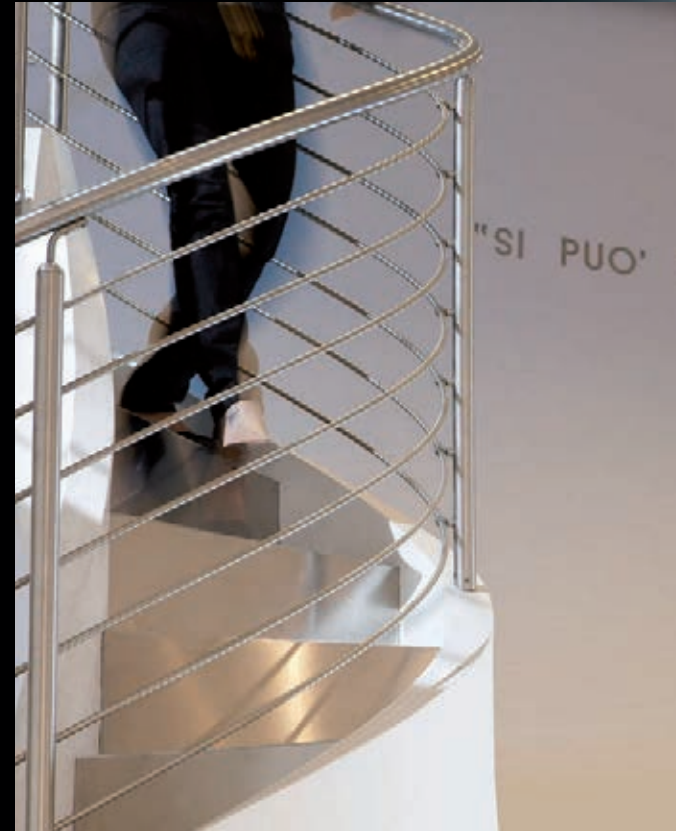
Scala elicoidale in cemento (diametro 140 cm) Concrete helical staircase (diameter 140 cm) Escalier hélicoïdale en béton (diamètre 140 cm)
