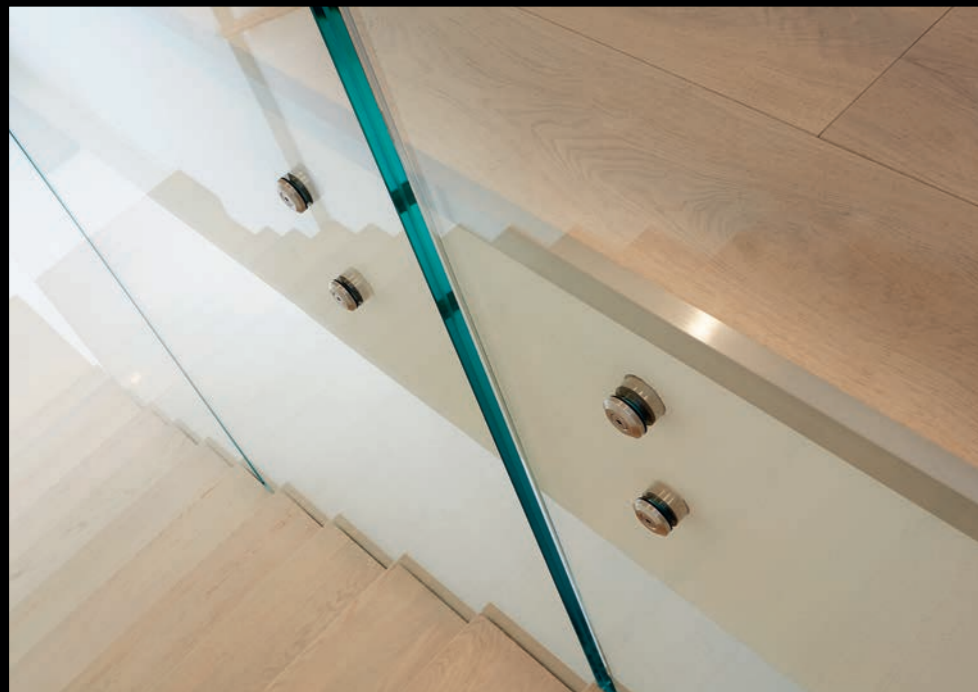
Scala a giorno con gradini a sbalzo in legno • Open staircase with cantilever wooden steps • Escalier à jour avec marches en porte-à-faux en bois
