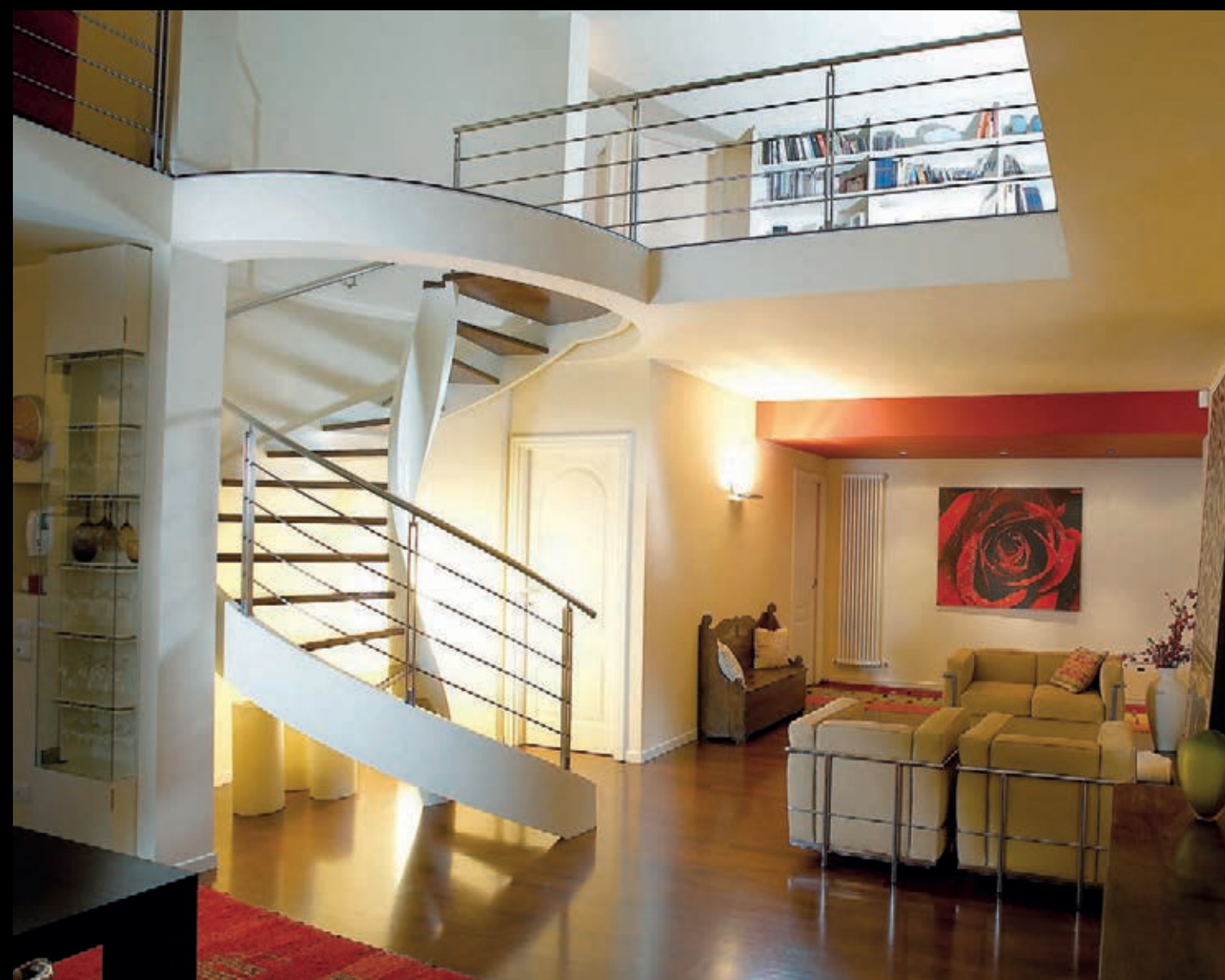
Scala elicoidale in legno (diametro 200 cm) • Wooden helical staircase (diameter 200 cm) • Escalier hélicoïdale en bois (diamètre 200 cm)
