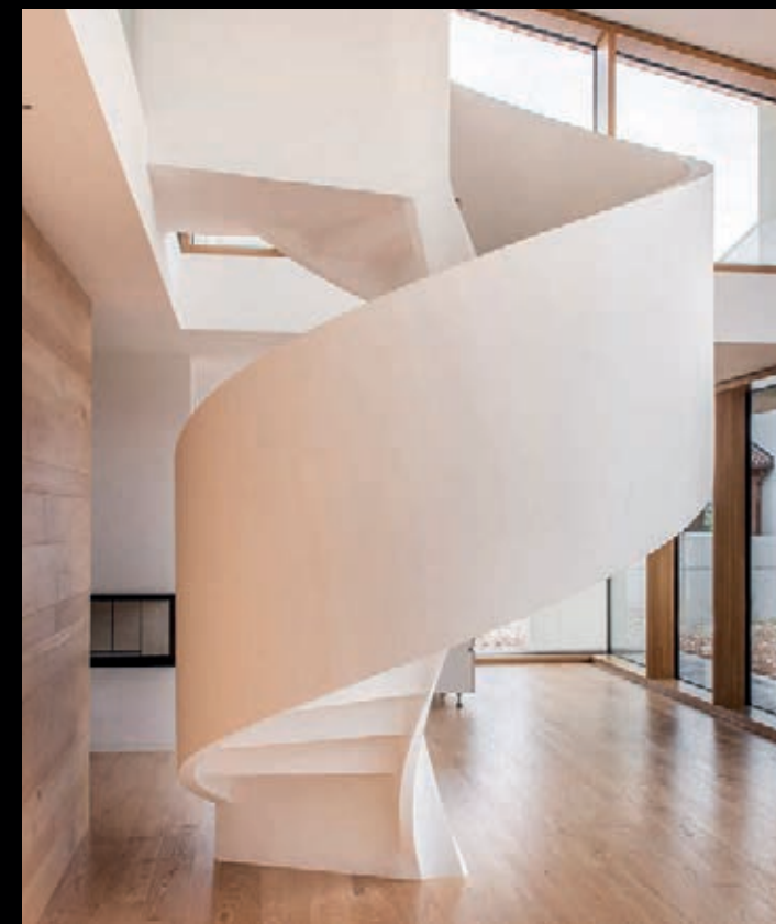
Scala elicoidale in cemento (diametro 220 cm) • Concrete helical staircase (diameter 220 cm) • Escalier hélicoïdale en béton (diamètre 220 cm)
