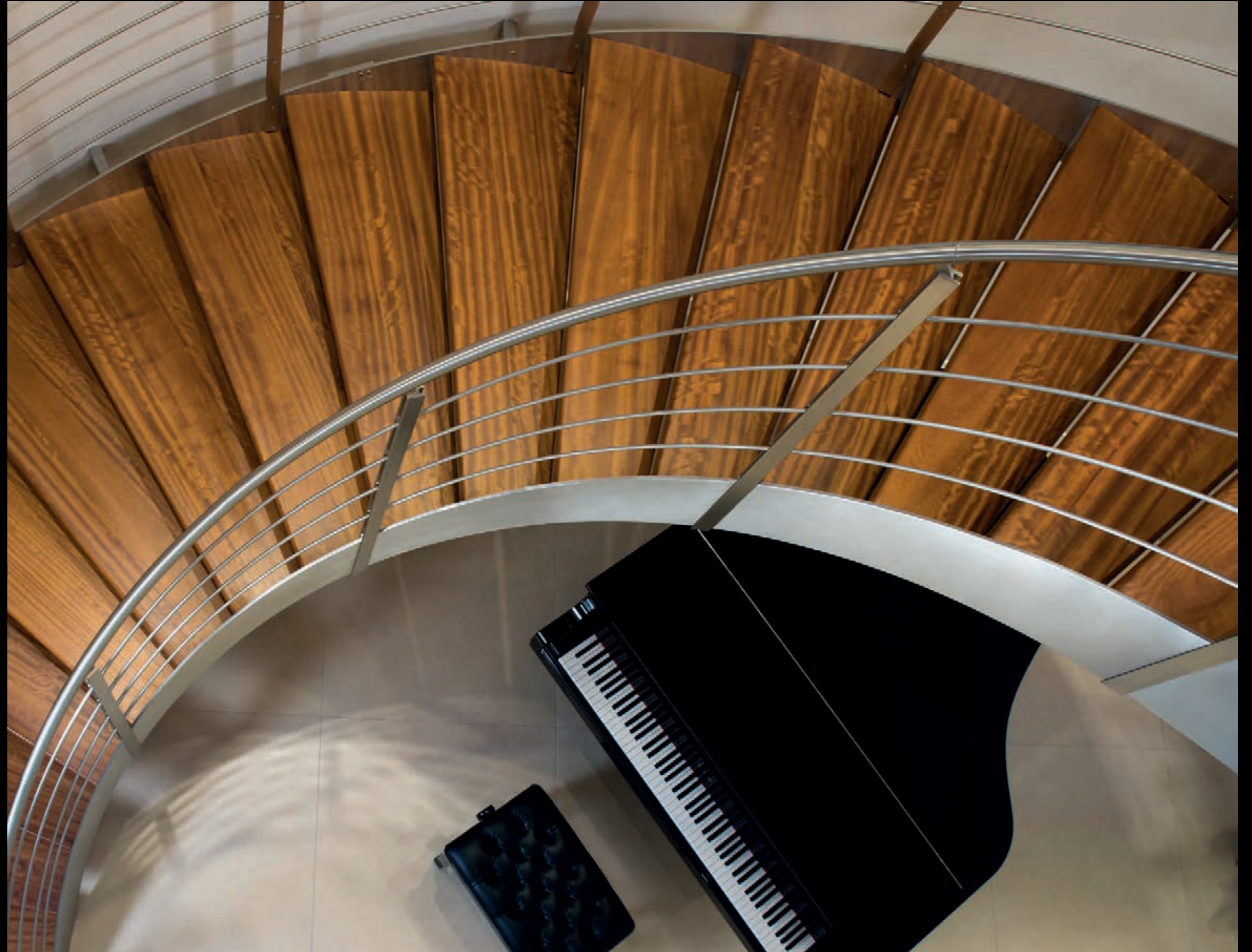
Scala a giorno in acciaio inox con gradini in legno • Open stainless steel staircase with wooden steps • Escalier à jour en acier inox avec marches en bois
