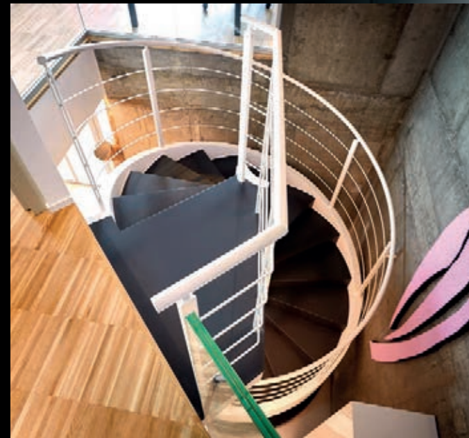
Scala elicoidale in cemento (diametro 220 cm) Concrete helical staircase (diameter 220 cm) Escalier hélicoïdale en béton (diamètre 220 cm)
