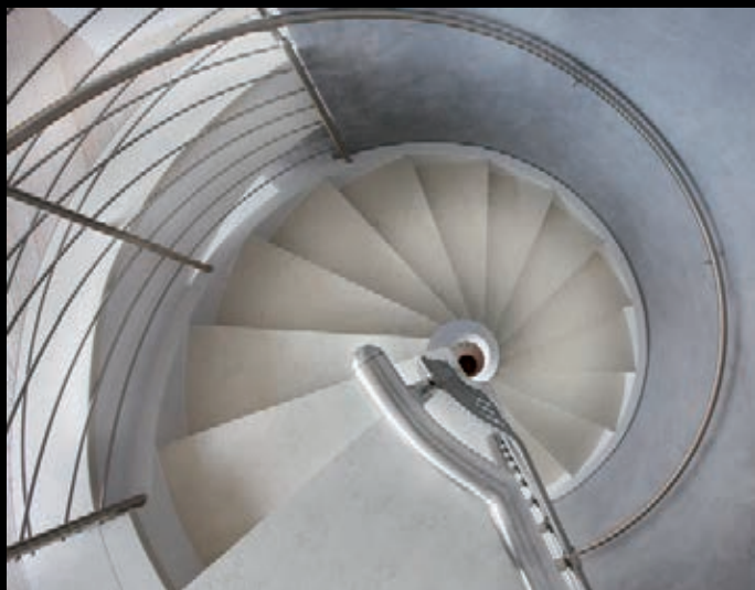
Escalier hélicoïdale en béton (diamètre 260 cm)
