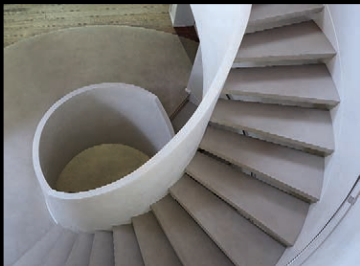
Scala a giorno doppia rampa Two flight open staircase Escalier à jour avec double rampe
