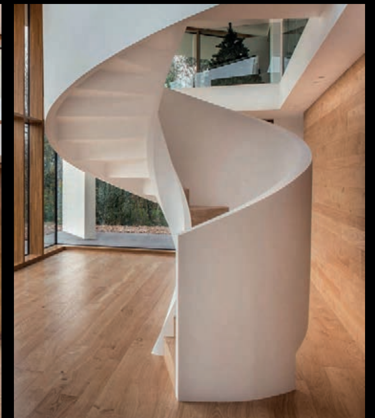
Scala elicoidale in cemento (diametro 220 cm) • Concrete helical staircase (diameter 220 cm) • Escalier hélicoïdale en béton (diamètre 220 cm)
