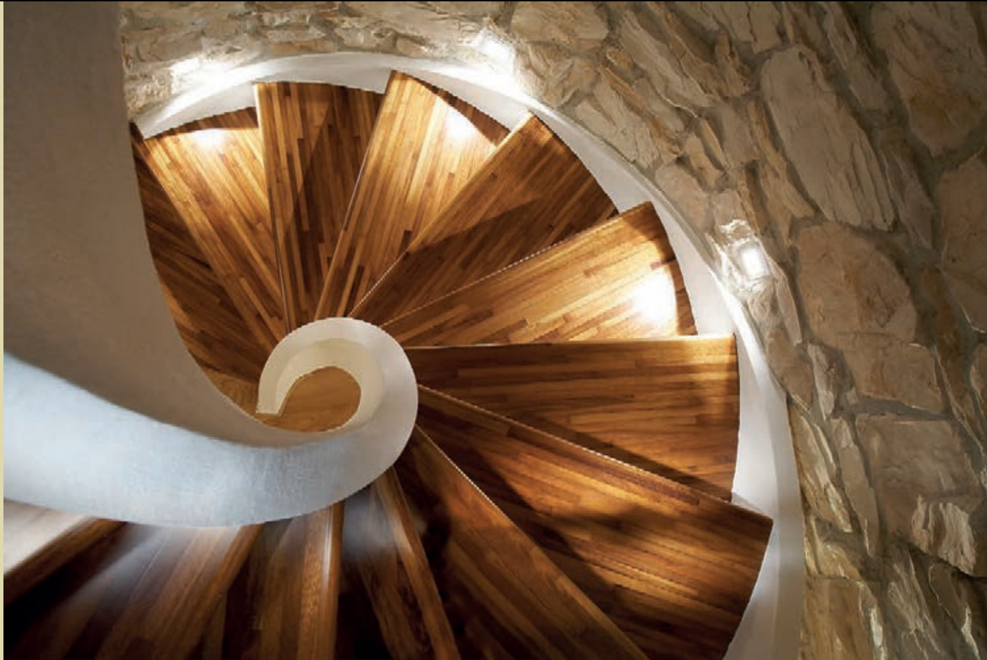
Scala elicoidale in cemento (diametro 220 cm) • Concrete helical staircase (diameter 220 cm) • Escalier hélicoïdale en béton (diamètre 220 cm)
